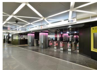
▲銀座駅改修工事 天井パネル
